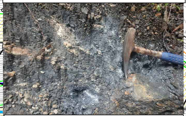
④ 上流側部に露出する断層破碎帯。
