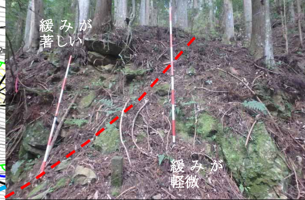
⑤ 下流側部：緩みの軽微な岩と緩みが著しい岩の境界付近に推定。
