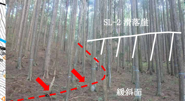
⑦ せり出し地形：SL-3 深層大ブロック下流側部の遷緩線 (SL-2 ブロック緩斜面を切って持ち上げる変位を示す)。
