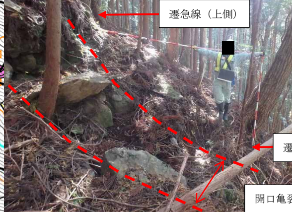
① 上流側部：開口亀裂帯に推定。開口亀裂帯を境に遷急線がずれる（水平 3m、高さ 2m）。
