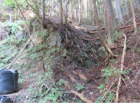
5 隣接する沢筋には破碎帯中の中石と見られる硬質な珪化変質した片麻岩が見られる。この沢に表流水はなく、崩壊地が浸潤する。
