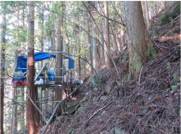
41 J4-7地点の足場状況と後背斜面状況。 ほぼ最下部遷急線付近に位置し、7m層厚の崖錐堆積物の分布が確認されている。
