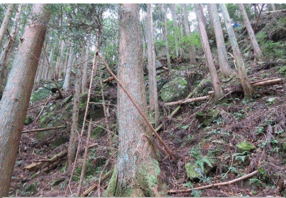
27 崩壊地頭部の遷急線直下には、せり出しと緩んだ岩盤の分布が見られ、落石が頻発している。
