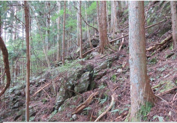
28 頭部崩壊地の状況。完全に分離した移動岩盤が斜面上に残存している。
