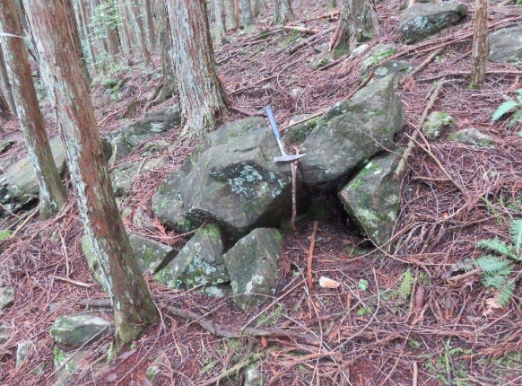
44 斜面中腹の緩斜面上に分布する岩塊。緩んでおり、風穴状の開口部が見られる。
