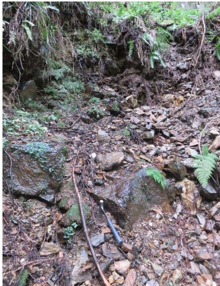
37 最下部遷急線直下の顕著な湧水点。 豪雨時には、表流水が顕著である。
