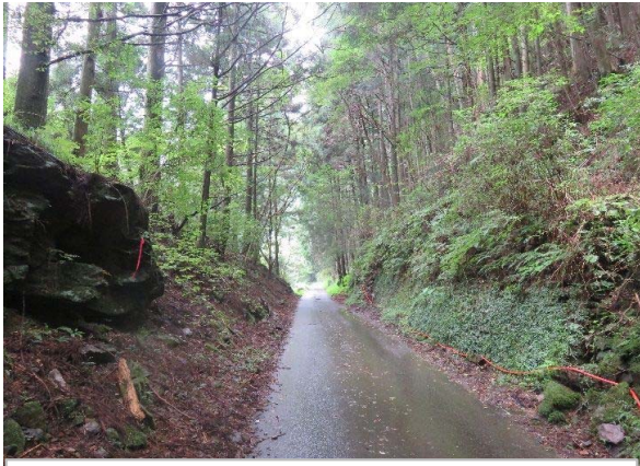
17 旧田口鉄道跡の町道平野松戸線の切割。崩落堆を切り割って、設置されている。
