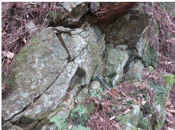
22 江ヶ沢に面する斜面の最上部遷急線直下。縞状片麻岩の硬質だが緩んだ岩盤が分布。
