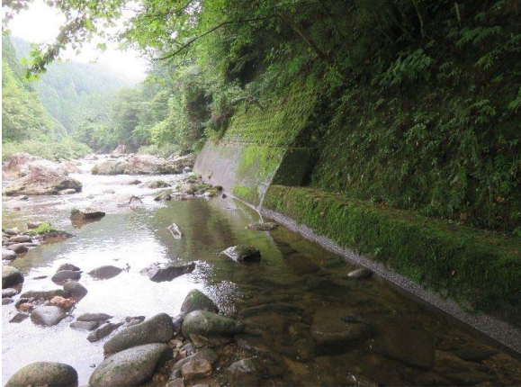
8 J4-8下の河床。規模の大きい護岸工が構築されている。堅岩の露頭はない。
