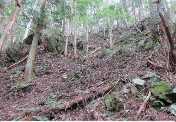
30 幅15～20m規模の岩盤崩落跡が連続している。残存尾根部が不安定化している。
