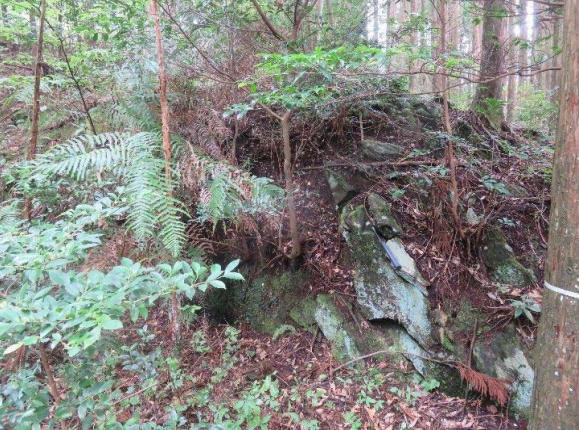
43 ブロック上部斜面の表層に見られる地すべり性の小岩盤ブロック。岩盤構造を完全に残している。
