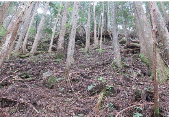
26 崩壊地頭部の遷急線付近の状況。
