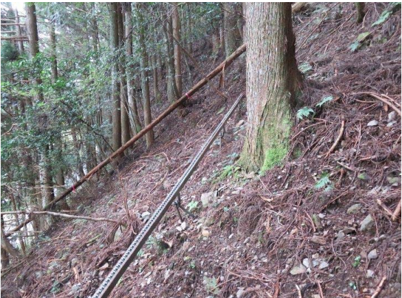
36 SS-13斜め上方斜面における湧水点。 常時の湧水が認められる。
