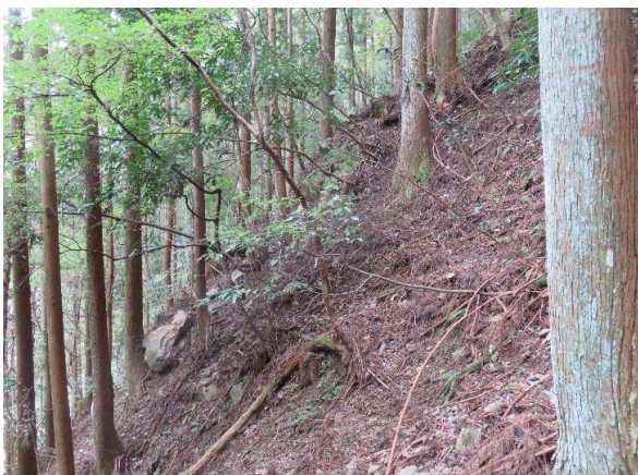
32 SL-2ブロックの北端付近では、最下部の遷急線の侵食によって上部斜面の不安定化が生じている。
