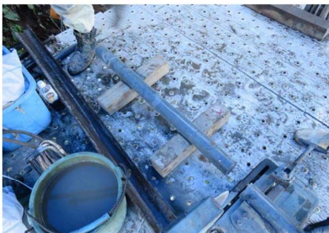
写真 3.3.3 仮受け樋上のコアを新たな 1m 長樋に載せる。
