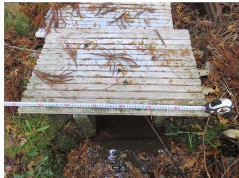
既存取水ますの蓋。幅70cm。
