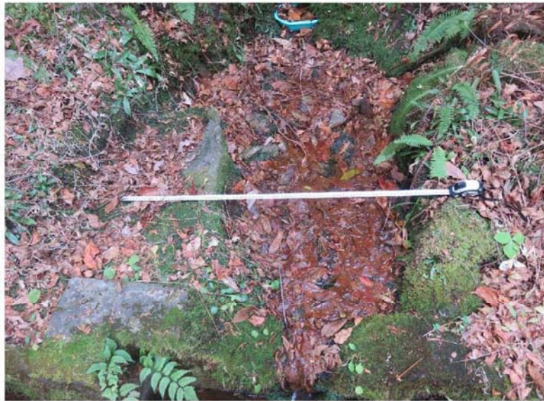
コンクリート堰背面の水路状況。標尺1m。
