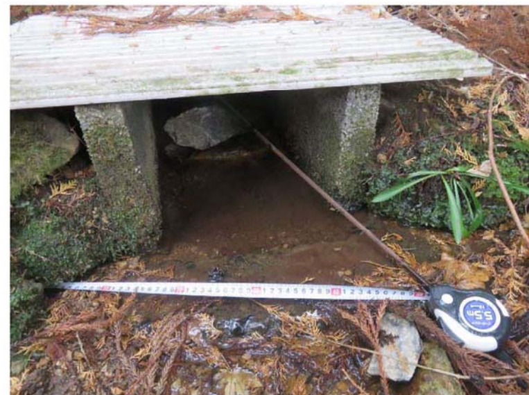
底部には現場打ちコンクリートの枠が設置されている。
