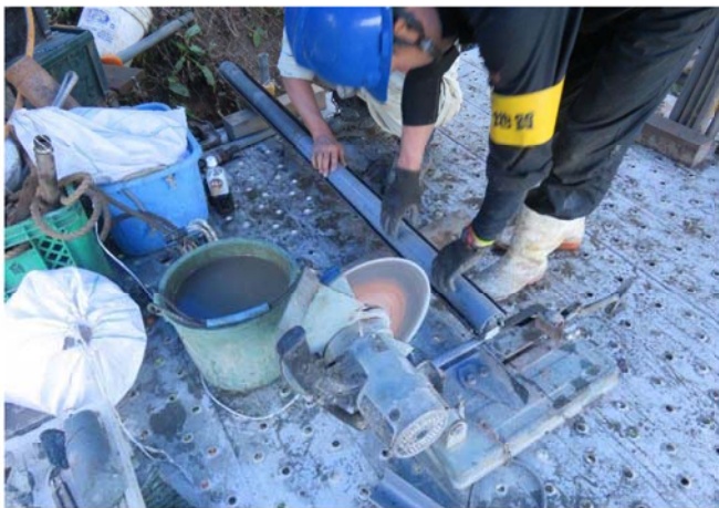
写真 3.3.1 仮受け樋に受けたコアに 1m 長塩ビ管被せ反転
