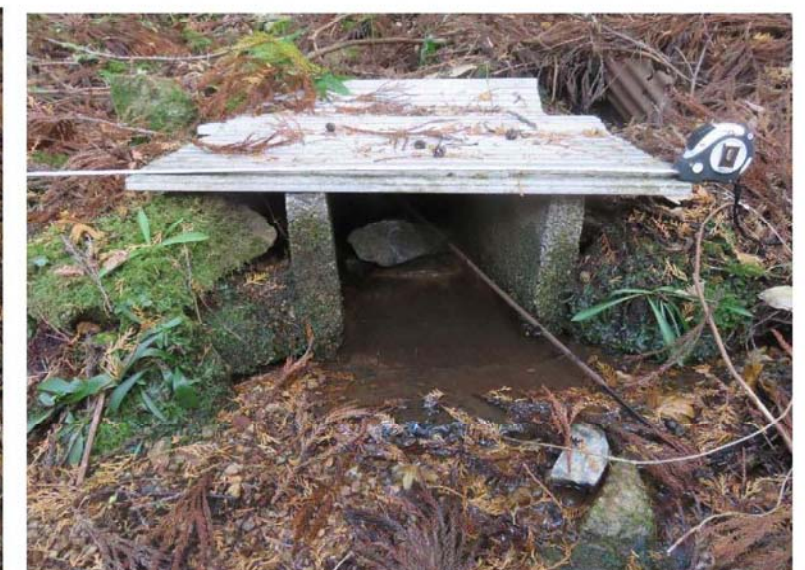
既存取水ますの内部状況。石(重し)の下が取水口。
