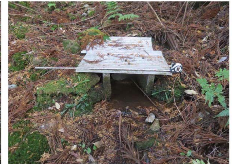
既存取水ます全景。標尺1m。取水口が内部にある。
