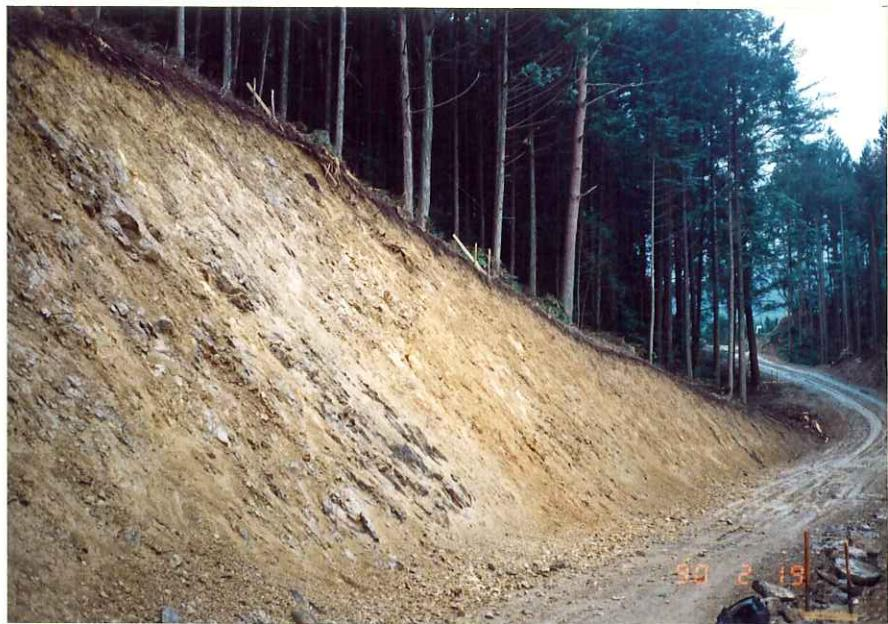
P-18 断層破碎帶（白い部分、幅 150cm）で泥質片麻岩と新第三紀層が接する。
