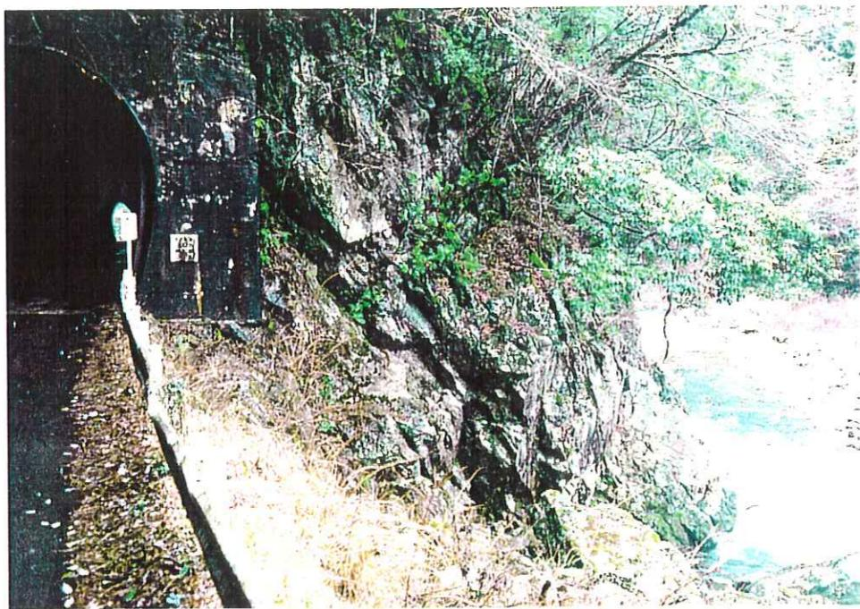
写真- 3 左岸河床トンネル上流坑口部の岩盤状況
