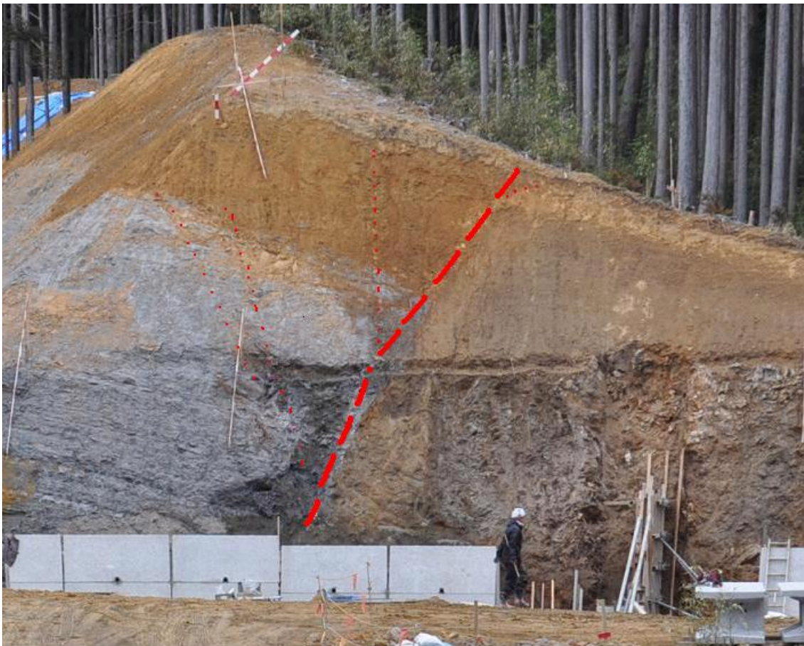
写真 1 設楽町田口地区西部の道路工事法面に現れた断層。 2016 年 4 月 2 日 筆者撮影。 表層の風化層まで、変位させていること、また、上盤側が上昇している地形が読み取れる。
