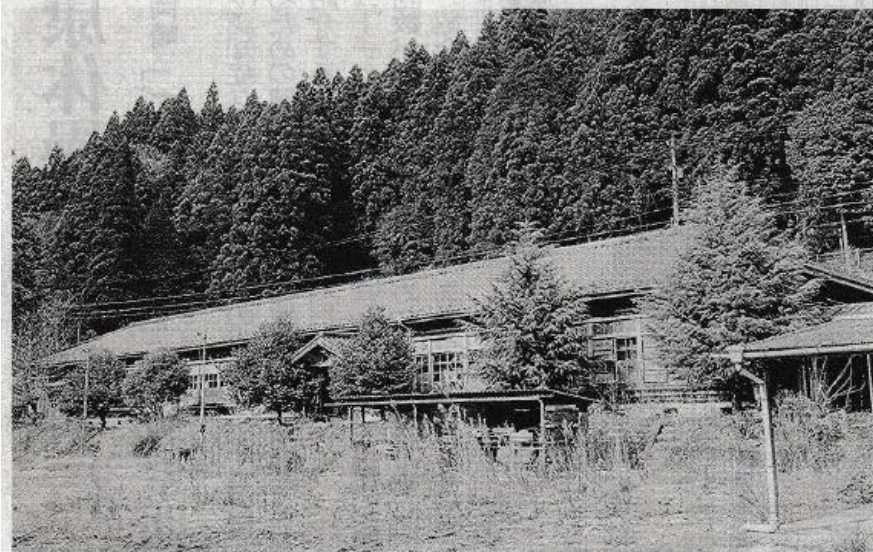
間もなく姿を消す旧八橋小の木造校舎＝設楽町八橋で
