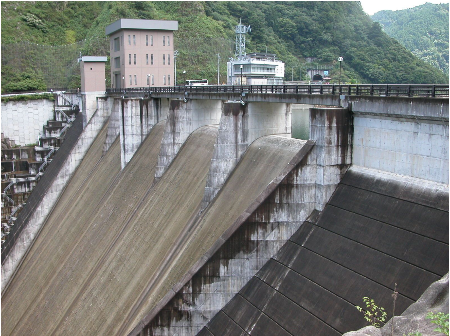
大島ダム 2001年度完成
