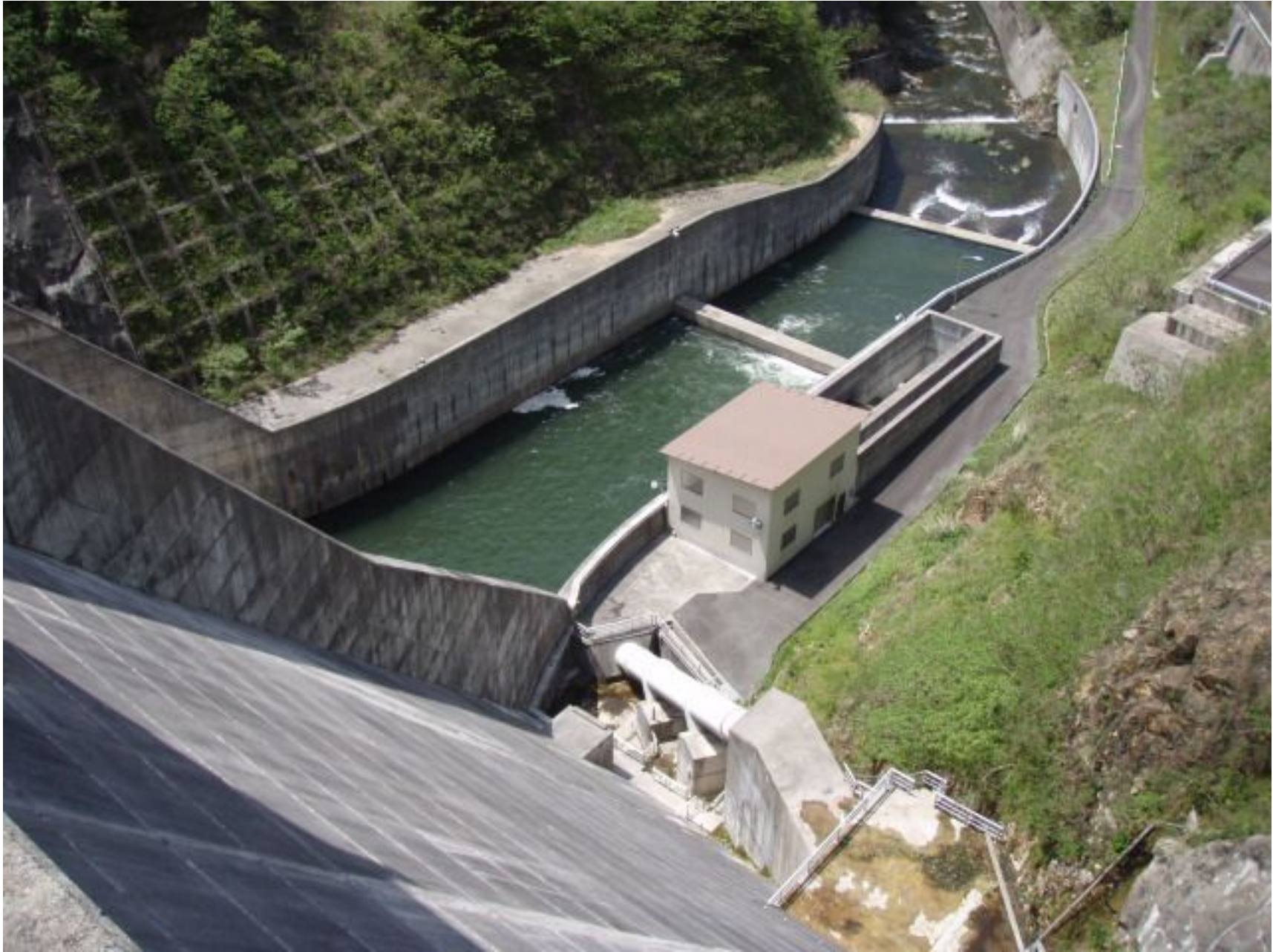
大島ダム 堰堤下、緑色の放流水
