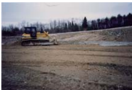
〔建設発生土の処理工事のイメージ〕
