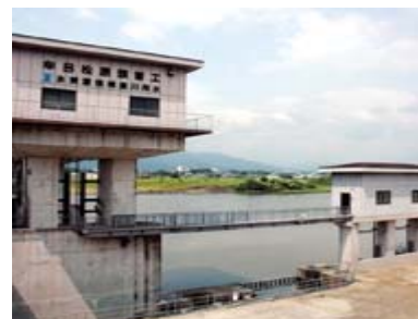
牟呂松原頭首工
