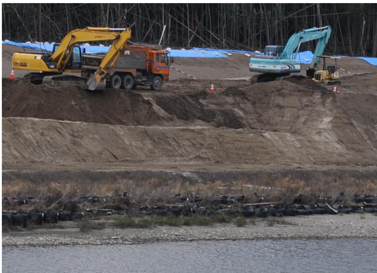
新城市一鍬田地区（24～25 km地点左岸側）の河道掘削工事（撮影 2013. 12. 12） 幅約 100m、長さ約 500m、厚さ約 5m の規模の土砂掘削が行われている
