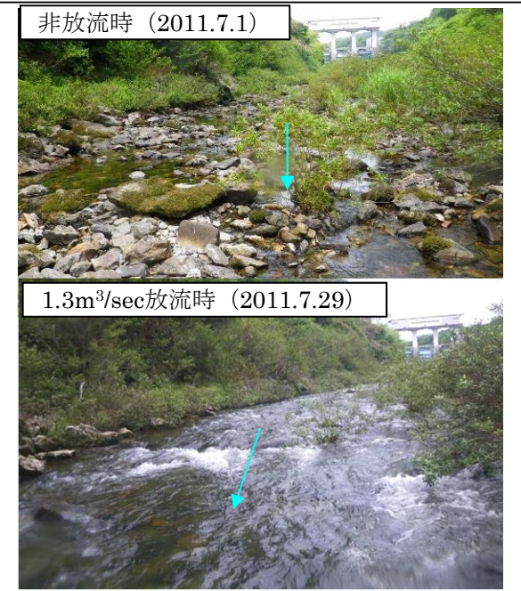
改善前後の状況(大野頭首工下流)
