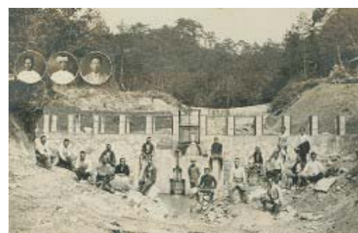
写真9 1929年建設当時の白坂量水堰(生態水文学研究所HPより引用)
